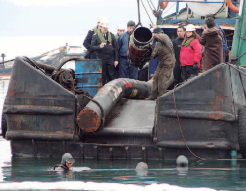
Producto del derrame de petróleo y como parte de una suspensión condicional, ENAP retiró los ductos submarinos de descarga y en su reemplazo construyó un muelle.
